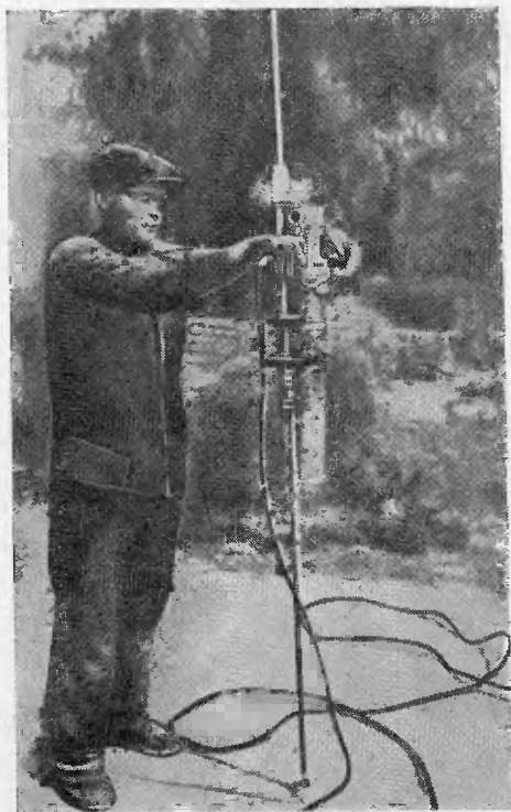
Рис. 35. Ввертывание электрода из круглого железа диаметром 10 мм посредством электродрели марки И-280-І.
