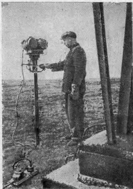
Рис. 37. Забивка глубинного заземлителя вибромолотом типа ВМ-2.
